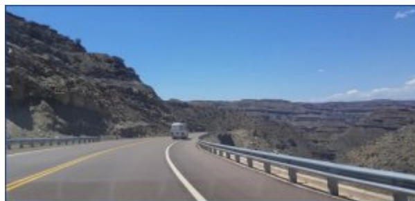
Photo 2. Tronçon de la route nationale 150
